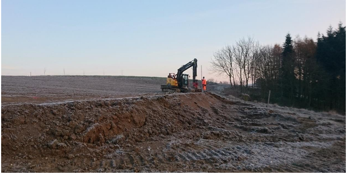
Aushub des Gewässers und Modellierung des Walls, Dezember 2020
