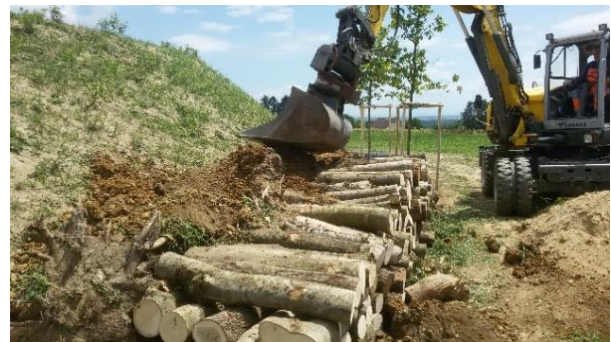
Aushub des Überwinterungsbereichs und Wiederverfüllen mit einem Gemisch aus Erde, Steinen und Holz
