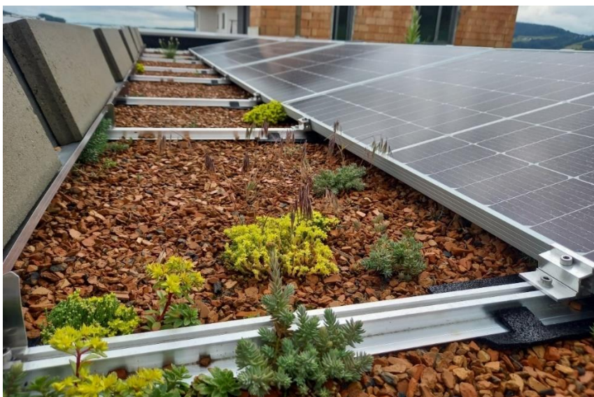
Zukunftsweisende Kombination aus Dachbegrünung und Photovoltaik, Sommer 2022
