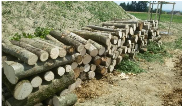
Holzstoss aufrichten und mit Erde hinterfüllen
