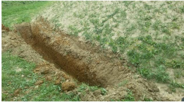
Aushub des Überwinterungsbereichs und Wiederverfüllen mit einem Gemisch aus Erde, Steinen und Holz
