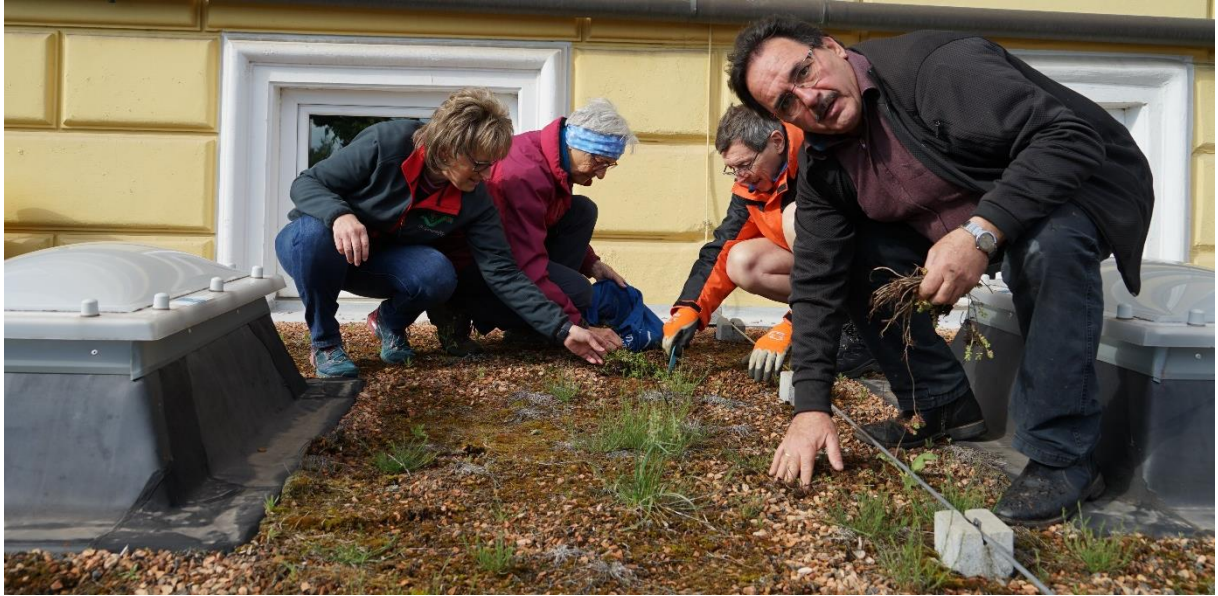
Pflege- und Pflanzungsarbeiten am Gründach Volksschule, Frühling 2024
