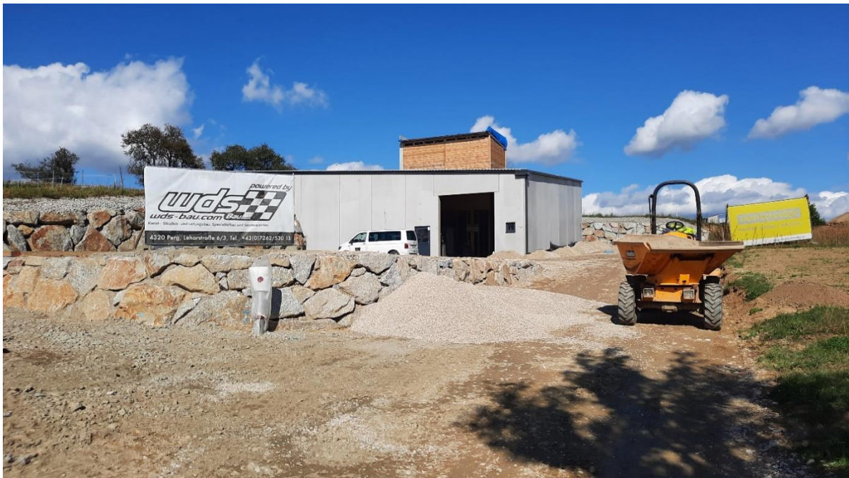
Bauphase beim neuen Biomasse-Kraftwerk, 2021
