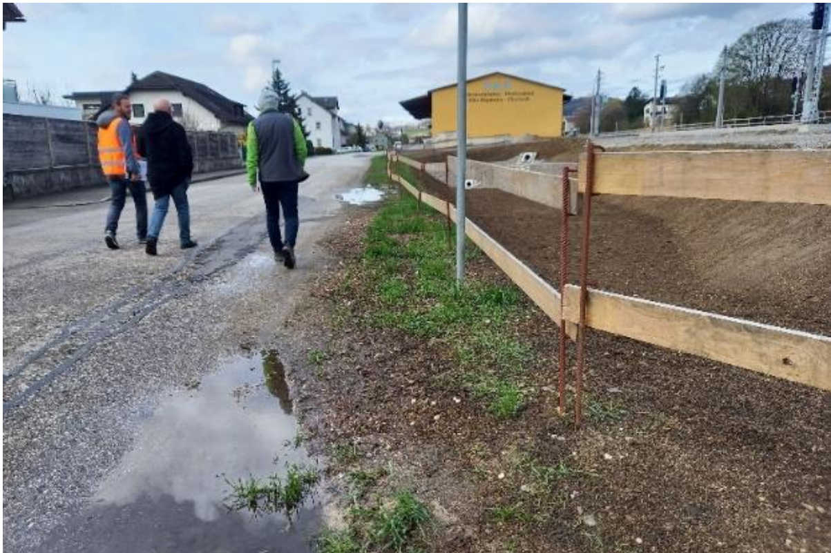
Gemeinsame Begehung auf der Baustelle
